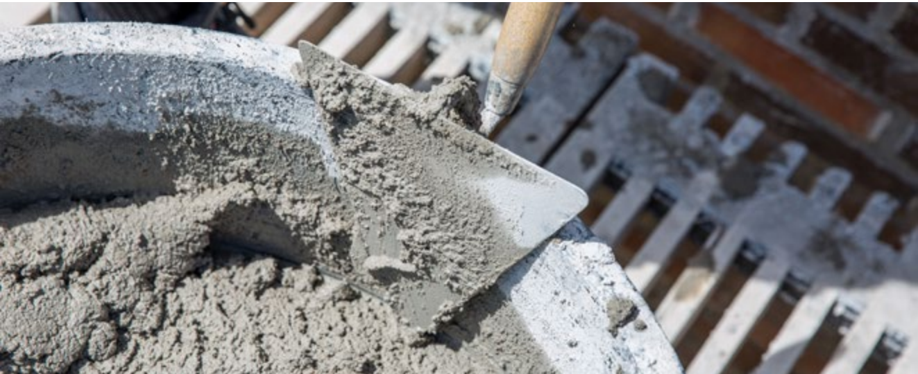
Detalje fra PensionDanmarks byggeri på Islands Brygge
