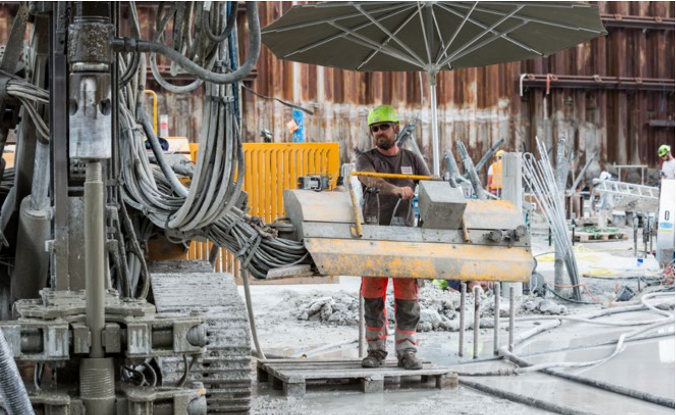
Kim er maskinfører hos Züblin og arbejder her på fundamentet af PensionDanmarks byggeri af Kronløbsøen
