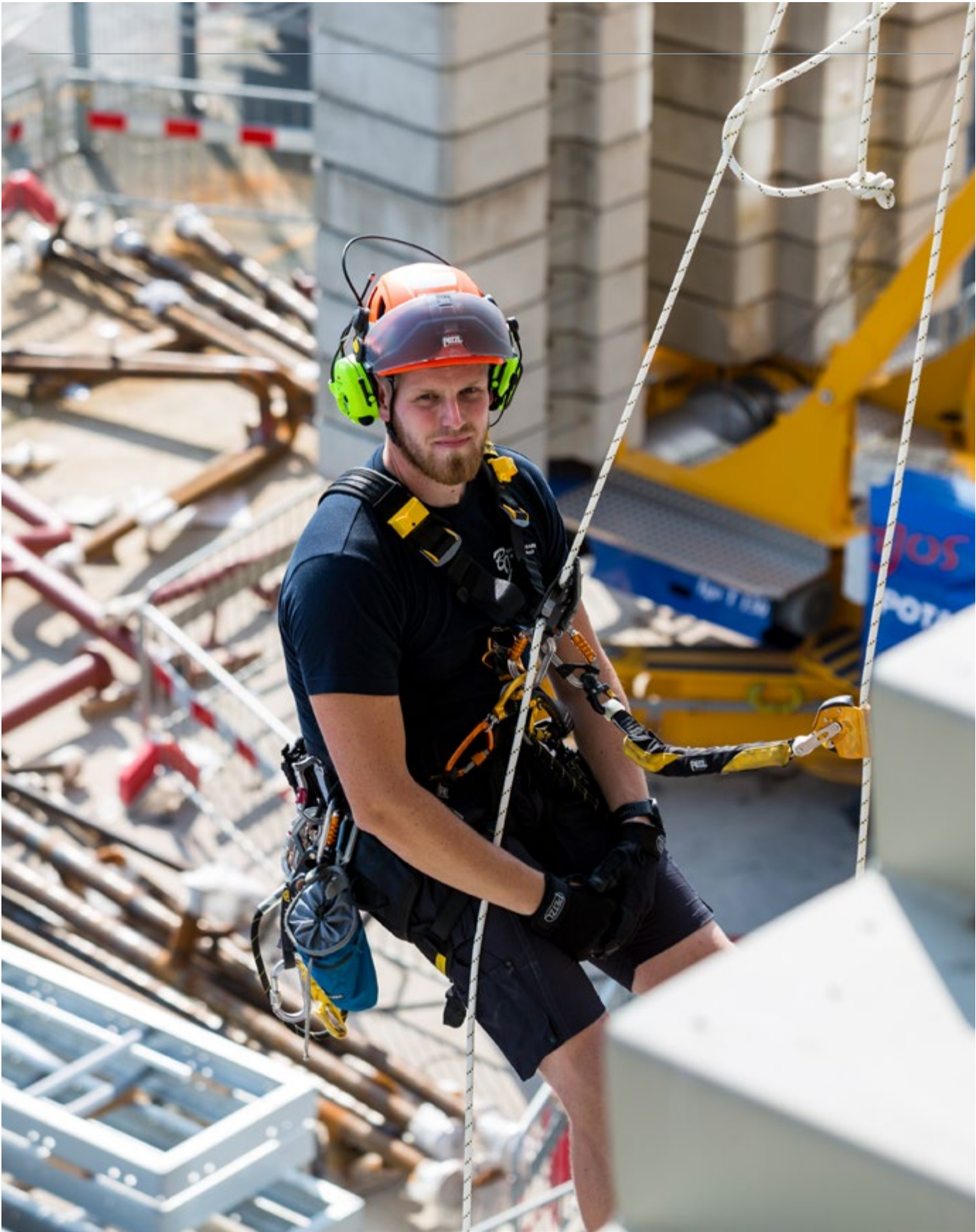
Erhvervsklatrer Mathias monterer vinduesfag på det kommende DFDS domicil og er medlem af PensionDanmark
