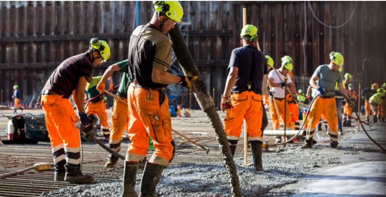
Cementstøbning på byggeriet af Kronløbsøen
