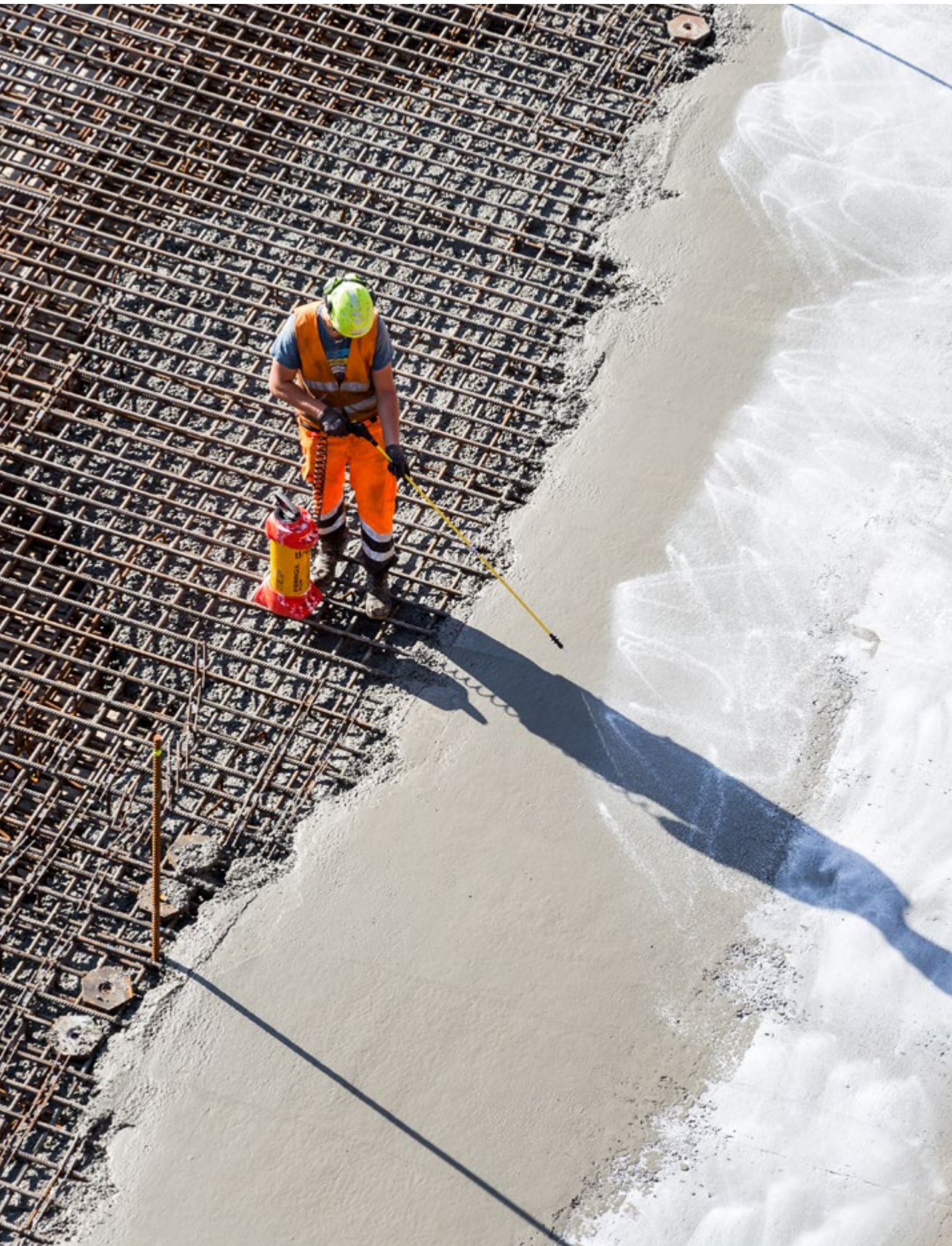
Støbearbejde på PensionDanmarks byggeri på Kronløbsøen
